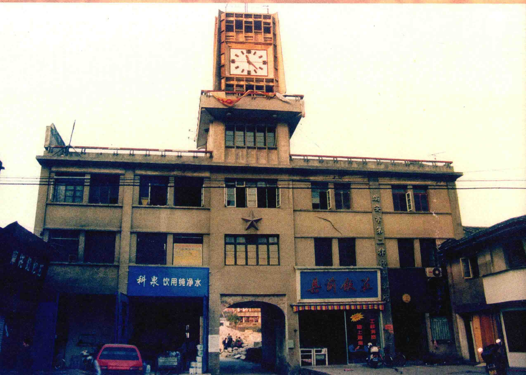
钟楼（位于解放中路）
