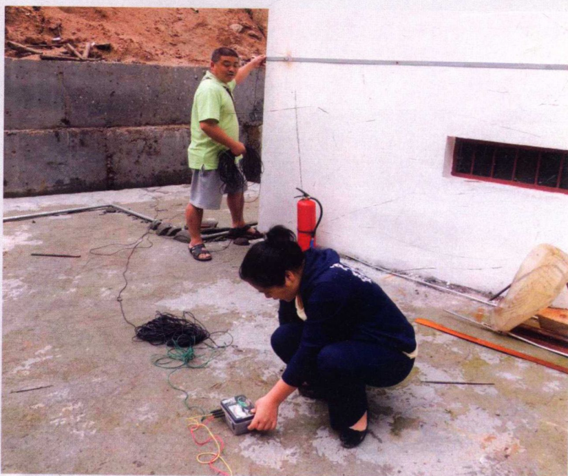
技术人员在开展防雷设施安全检测
