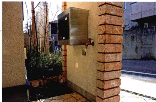
独特的多功能门柱充满了自由幻想的空间。内侧的墙壁上安置了水龙头，安装的软管卷轴从外面完全看不见。
