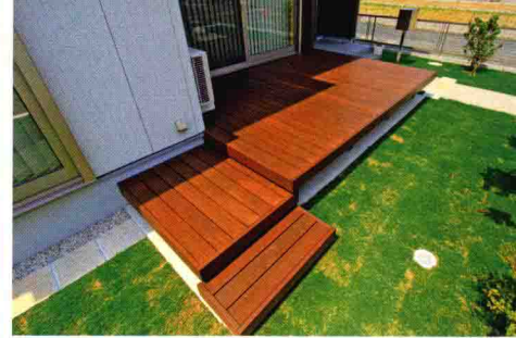
② 铁质木材连廊采用三段式造型。
