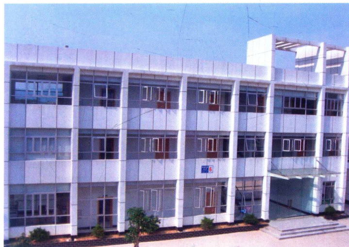
2007年建成的佛冈县气象局办公楼（2007年7月摄）
