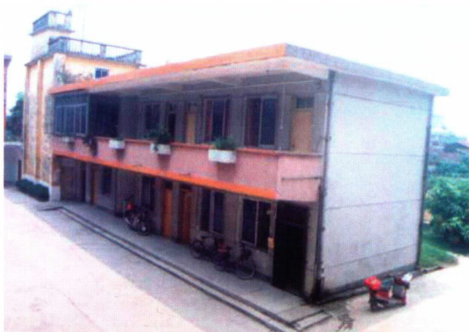
1993年建成的佛冈县气象局办公楼（1999年9月摄）
