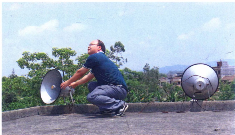
建成覆盖全县 各行政村的气象预 警大喇叭系统
