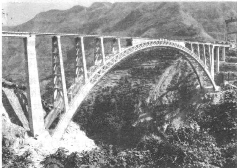
图 1-1 大跨度钢管混凝土拱桥
