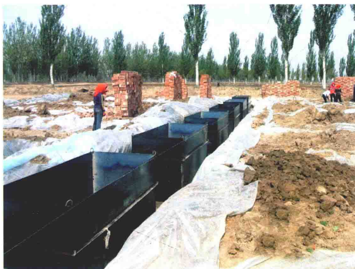
图1 农田水分渗漏及氮磷运移试验基础设施建设
