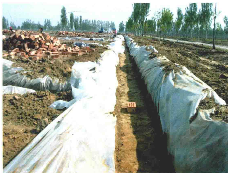
图2 田间试验小区防渗漏基础设施建设
