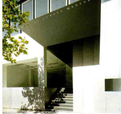
公司办公楼入口 Office entry
