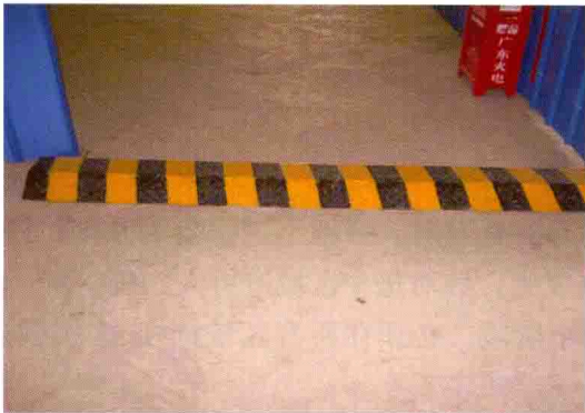
图 7-1-4 过路临电电缆保护
