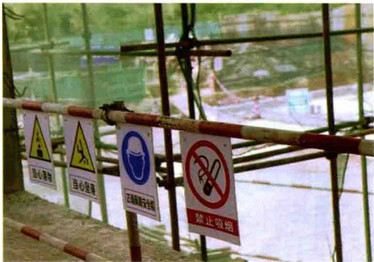
图 7-1-9 楼层临边遮栏围护
