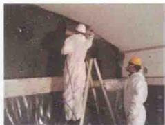
Emisshield高发射率涂料是基于人工合成的无机材料，工作原理是将热量吸收并将该热量发射到低温物体。玻璃窑用耐火材料的发射率一般在0.4~0.6，当窑炉内衬材料涂上Emisshield以后，提高了内衬表面的发射率，更多的热量被吸收之后再发射回窑炉内部低温物质（玻璃液、原料），减少热量的损失，从而提高了热量的利用率。
