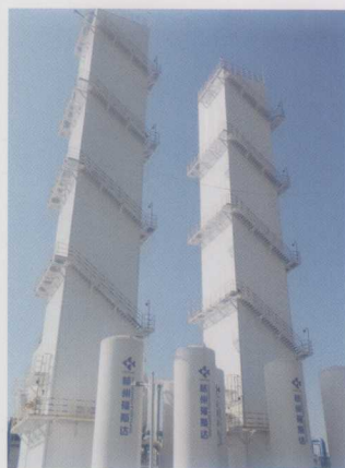
沈阳科达两套 GOX10000m 3 /h 带氩空分设备
