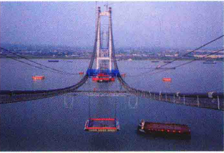
▲ 首段钢箱梁吊装
