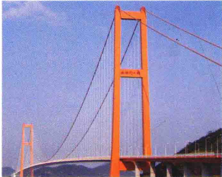
▲ 建成后的舟山西堠门大桥
