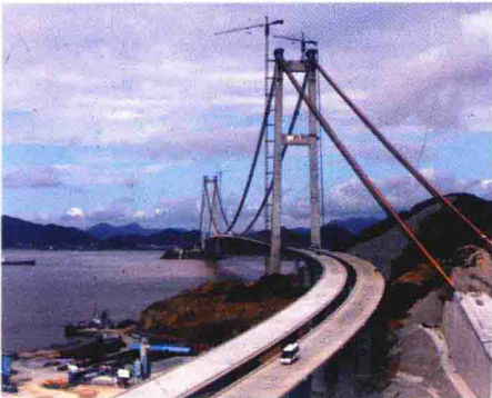
▲ 主缆及南引桥全景
