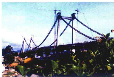
▲ 上部结构施工
