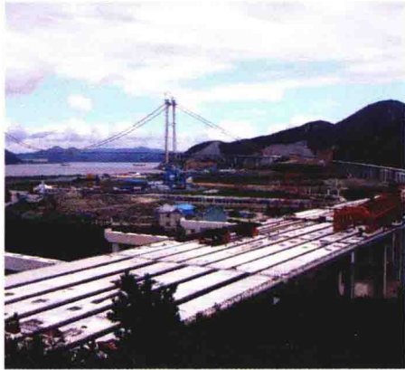
▲ 主桥及接线工程全景
