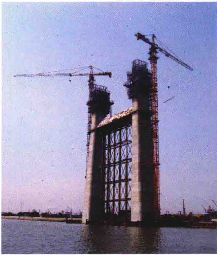
▲ 北塔施工场景
