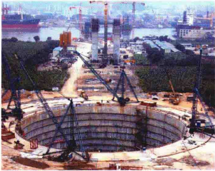
▲ 锚碇基础施工场景
