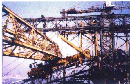
▲ 主缆跨缆吊机拼装
