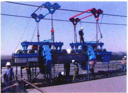
▲ 主缆紧缆施工
