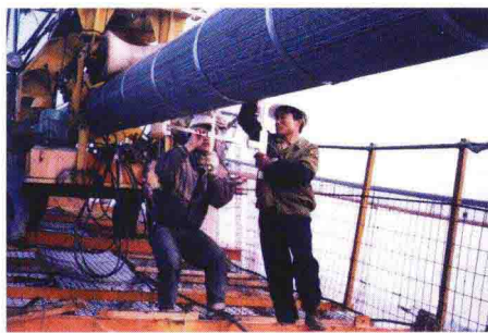
▲ 主缆紧缆施工
