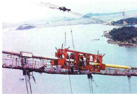
▲ 主缆缠丝施工
