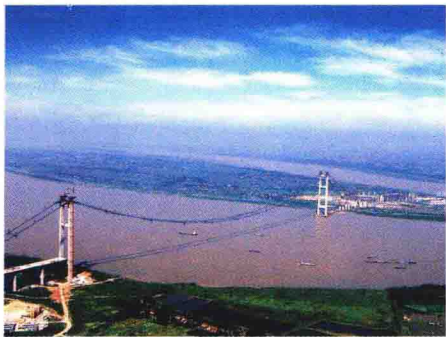
▲ 上部结构施工全景
