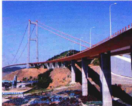
▲ 全桥涂装期间全景
