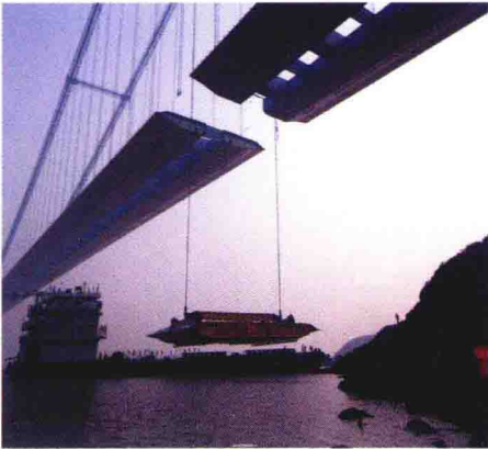
▲ 钢箱梁合龙段吊装
