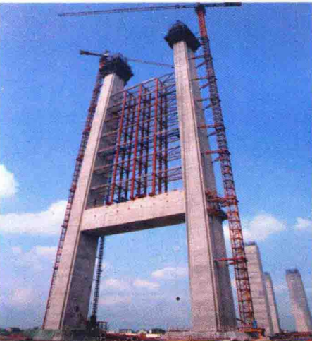
▲ 北塔接高施工
