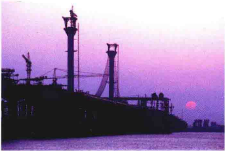
▲ 上部结构施工场景
