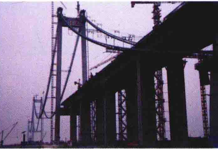
▲ 主缆施工完毕
