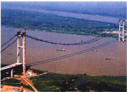
▲ 猫道架设完成
