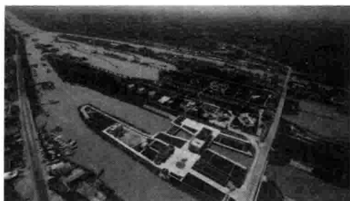
京杭运河苏北三线船闸
