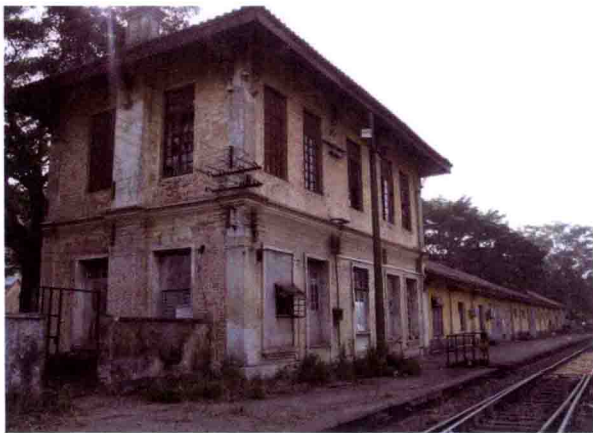
广三铁路三水站旧址
