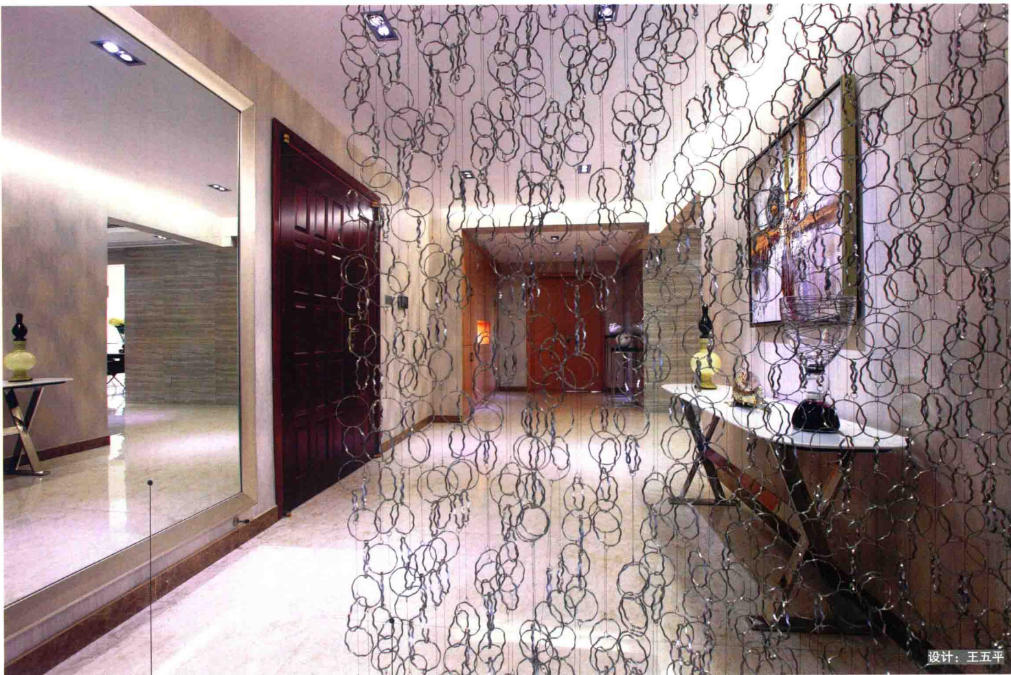
夹板打底面贴灰镜
