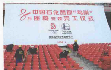
2008年1月28日，燕山石化提供聚丙烯专用料生产的奥运座椅在“鸟巢”安装完毕
