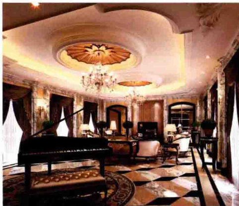
顶面 [ 石膏板造型 + 石膏浮雕刷金漆 ]
