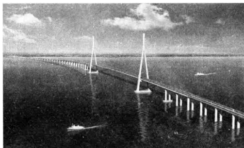
图 1-1-12 苏通长江公路大桥
