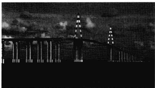
图 1.2-5 Saint-Nazaire Bridge(圣纳泽尔桥)
