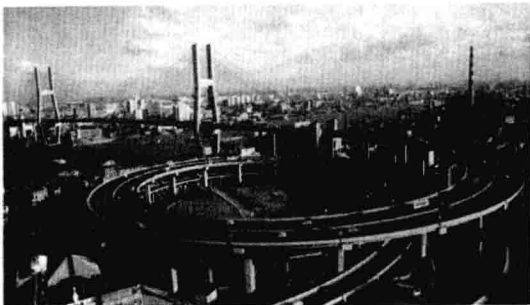
图 1.2-12 上海南浦大桥
