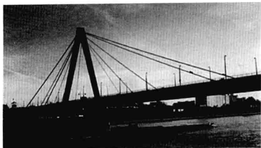
图 1.2-3 Severins Bridge(塞弗林大桥)
