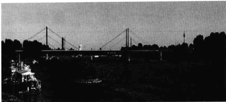
图 1.2-2 Theodor Heuss Bridge(特奥尔多豪斯桥)
