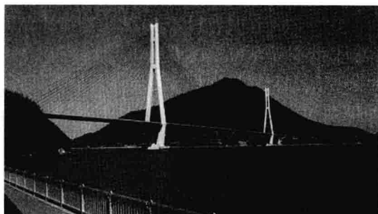
图 1.2-10 Tatara Bridge(多多罗大桥)
