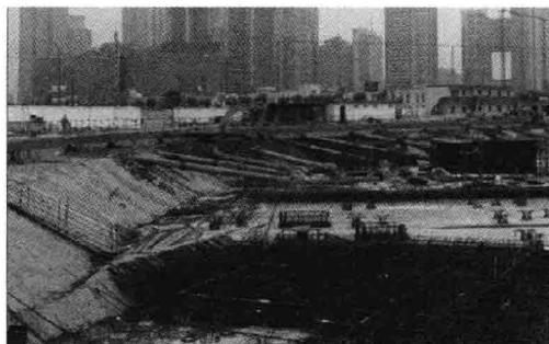
图 0-4 深基坑支护
