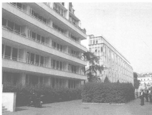
图 1.11 巴黎实例——将办公空间转变为住宅
