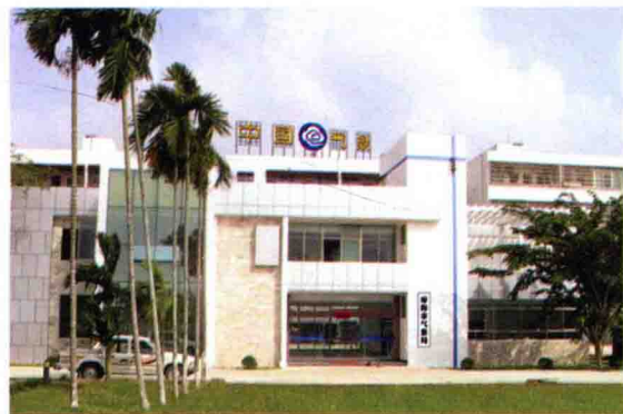
2006年10月建成的琼海市气象局办公楼
