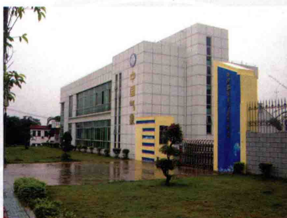
2006年建成的白沙黎族自治县气象局办公楼
