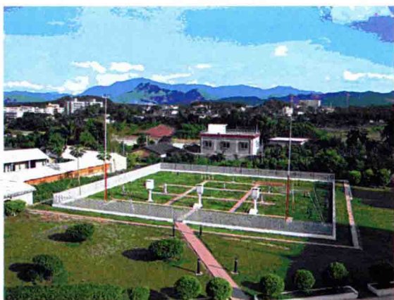
2004年建成的白沙黎族自治县遥测自动气象站
