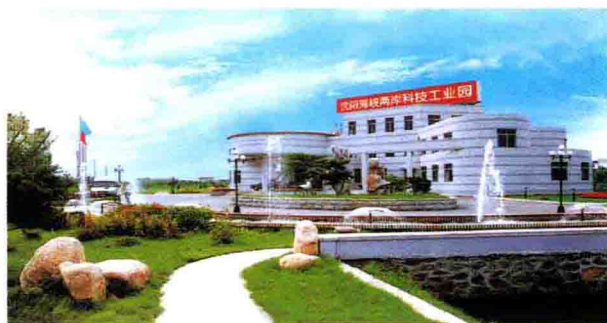
沈阳海峡两岸科技工业园。
