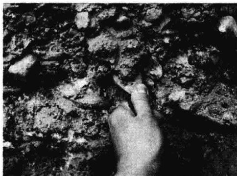
图1-1 开挖后戈壁地基断面结构
