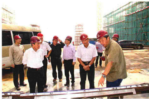
2012年9月27日 董瑞龙主任到园博馆施工现场调研
