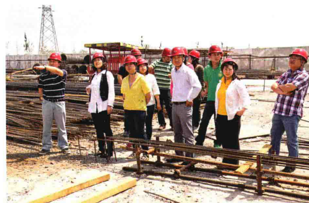
2012年5月4日 国博馆筹建办青年团员到国博馆施工现场参观
