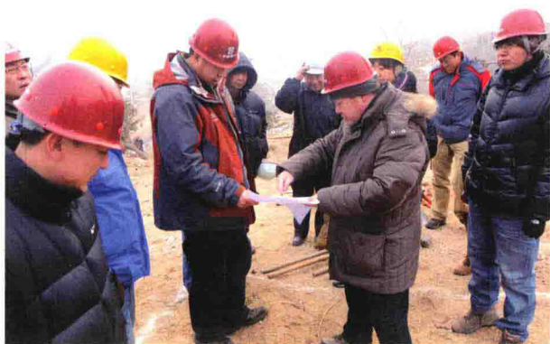
2012年2月25日 国博馆室外展区植物种植施工现场
