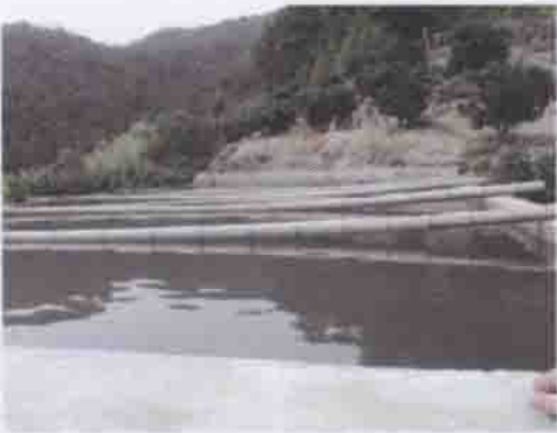
药肥水一体化 水池
