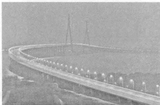
图 1.4 苏通长江公路大桥
