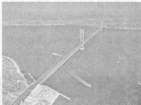
图 1.6 明石海峡大桥
