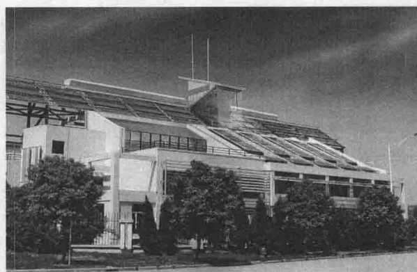
图 1-10 上海生态办公示范楼（绿色建筑）
