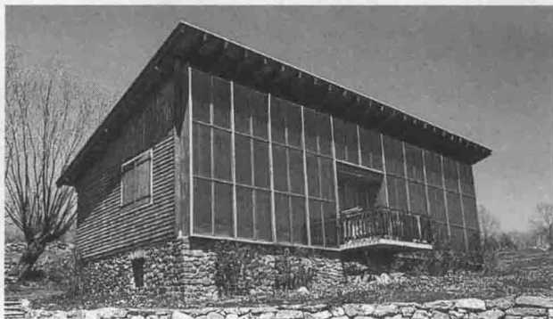
图 1-4 位于奥代罗的第一座集热蓄热墙式太阳房
