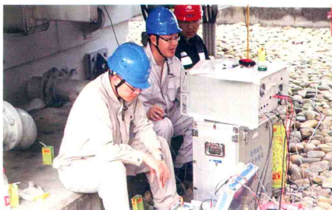
图 1-4 感应耐压及局部放电试验现场
