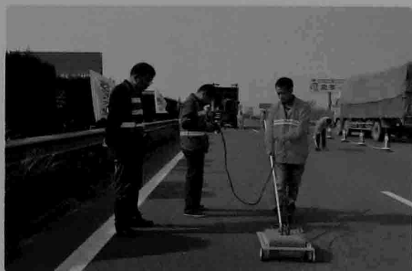
探地雷达进行检测路面裂缝
