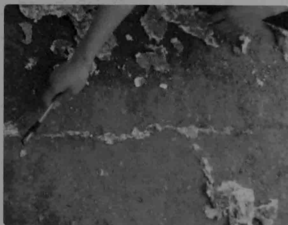
施工后表面图
