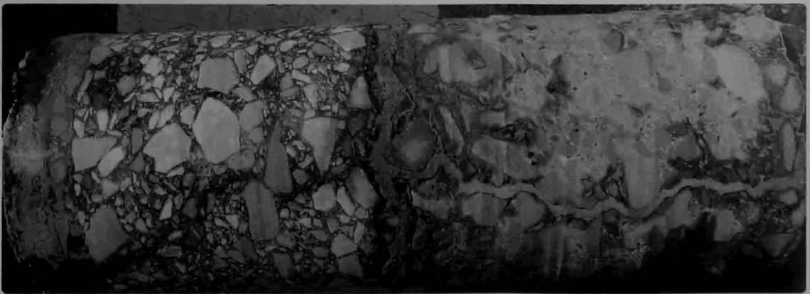
反射裂缝焊接（沥青面层与基层有脱空）
