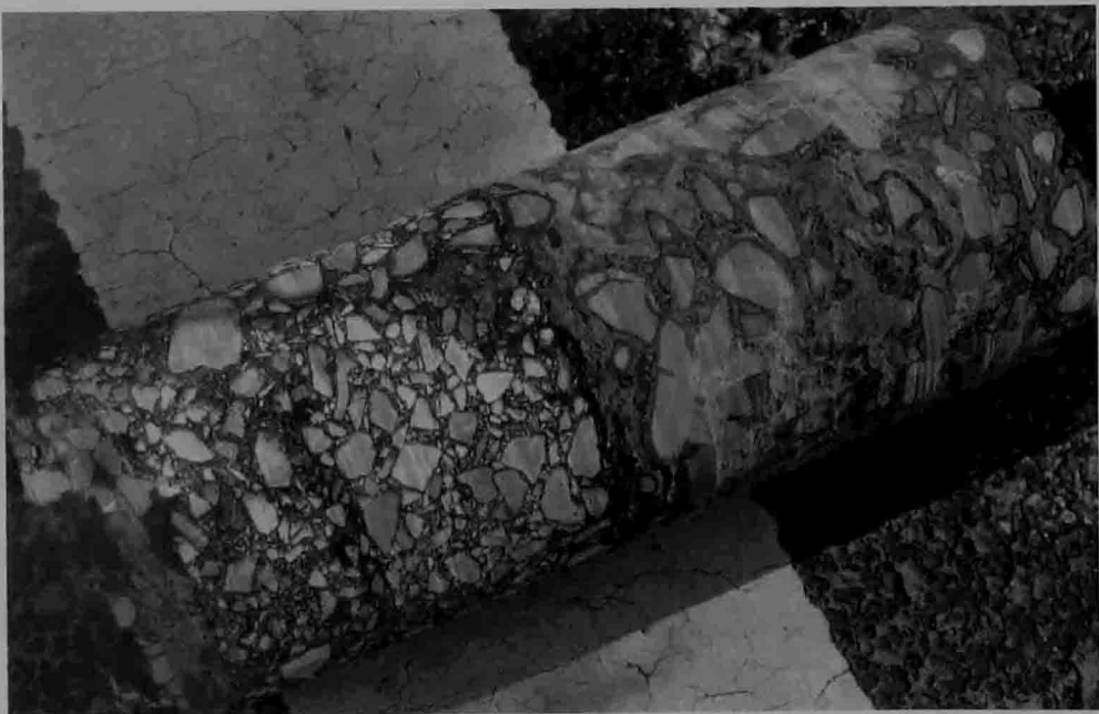
反射裂缝焊接（基层有松散）
