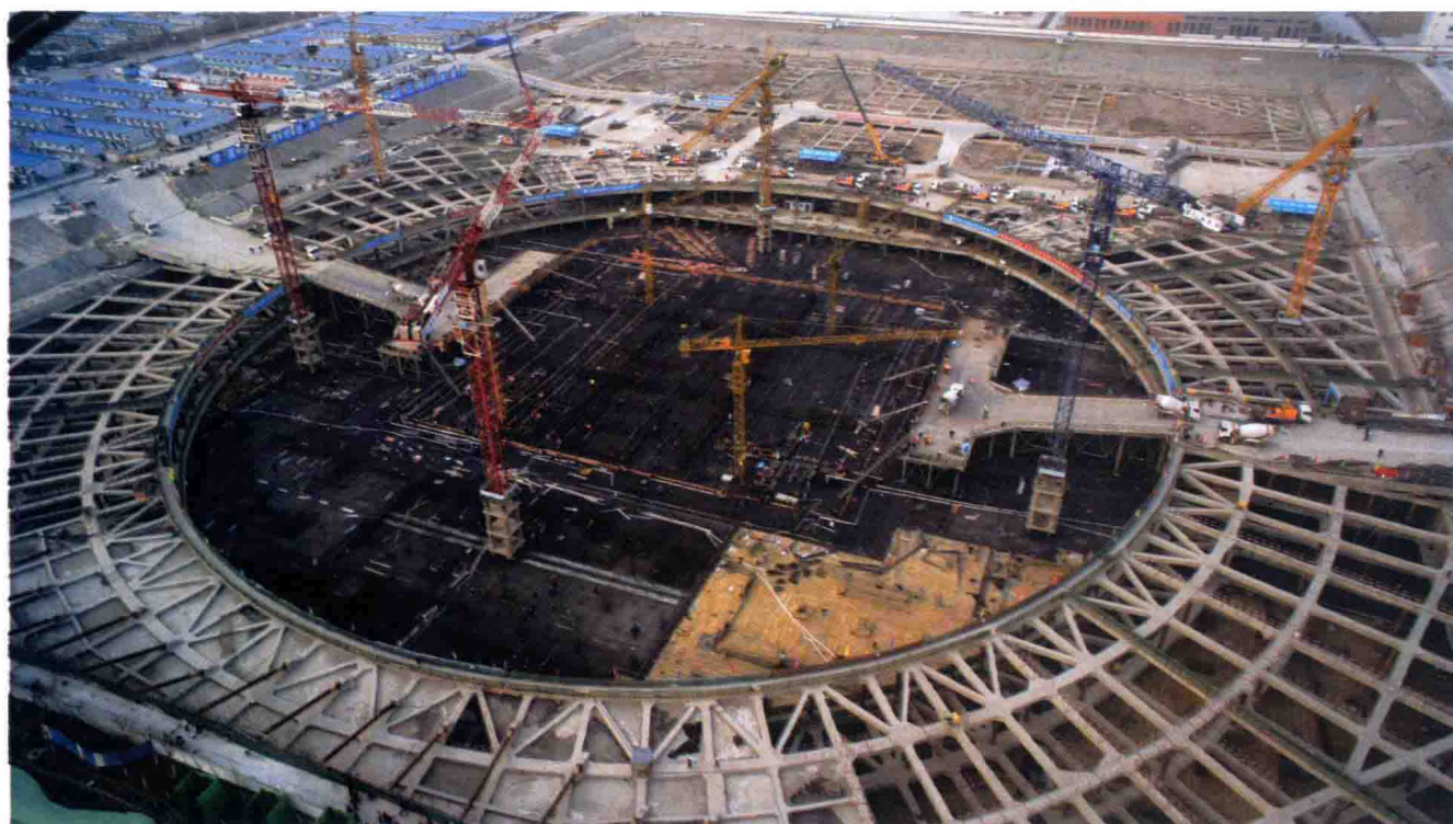
天津117大厦大底板施工
