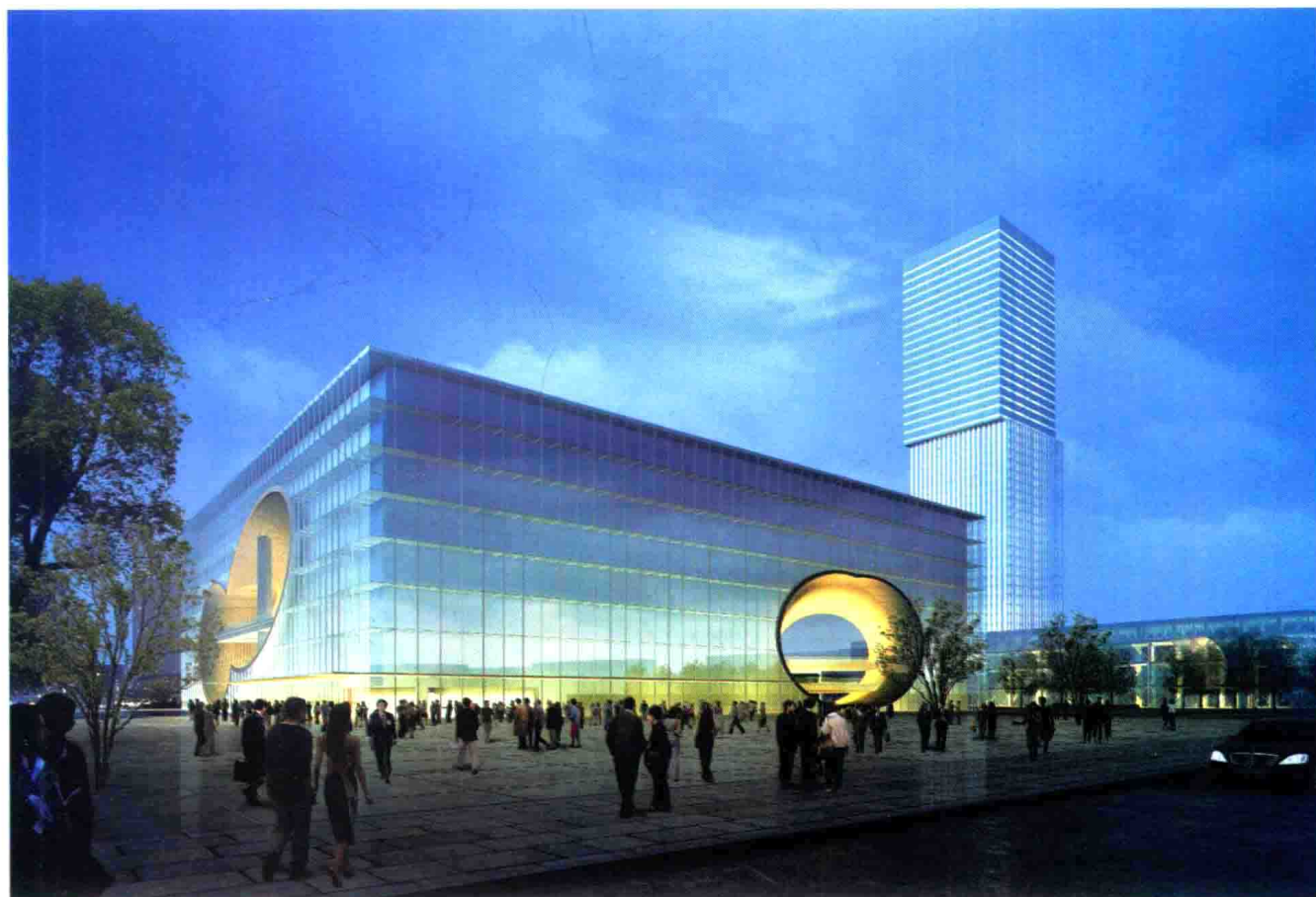
上海保利大剧院工程
