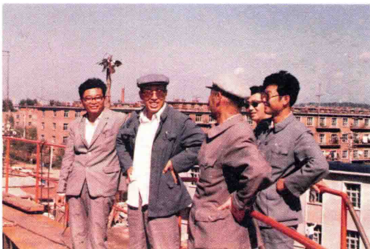
1986年，肖作福（左二）与铁岭市建委主任刘廷耀（左一）和铁岭市建委副主任刘树元（右一）视察煤气建设工地
