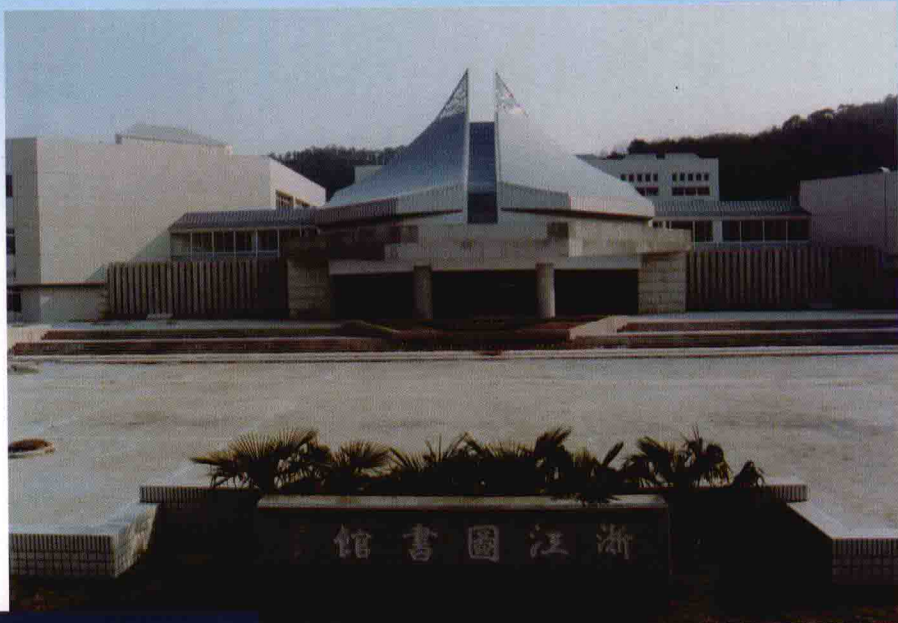
浙江图书馆新馆建筑面积 3.08 万平方米，土建总投资 1.2 亿元。
