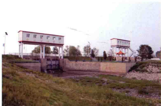
滞洪区泄水闸
