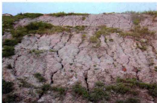
库里泡滞洪区泄水闸右堤分散土
