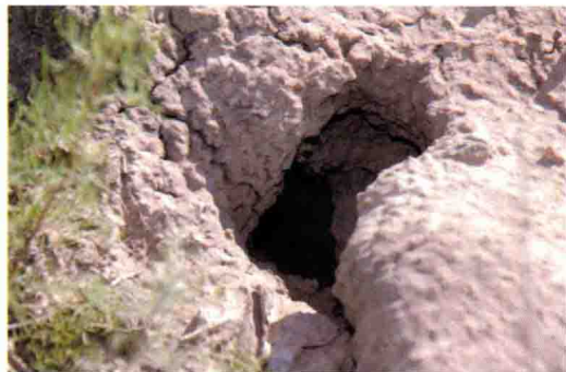
分散土破坏堤体
