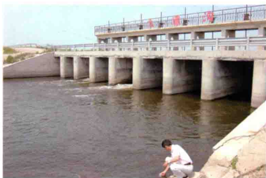
东升水库泄水闸
