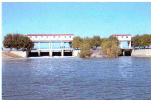
滞洪区泄水闸
