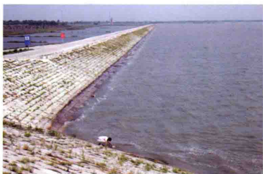
南引水库 21 号坝处理后迎水面护坡
