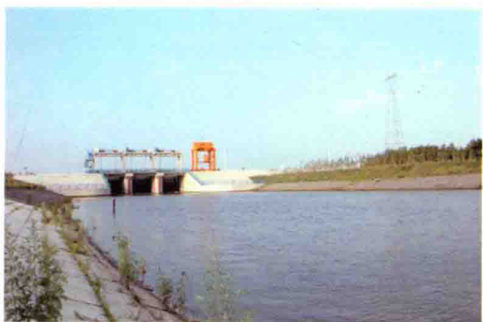
北引渠道进水闸
