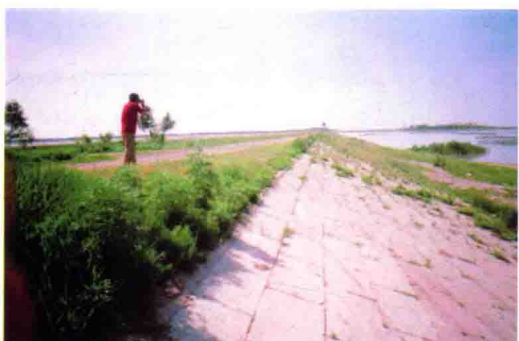
南引水库 17 号坝迎水面护坡
