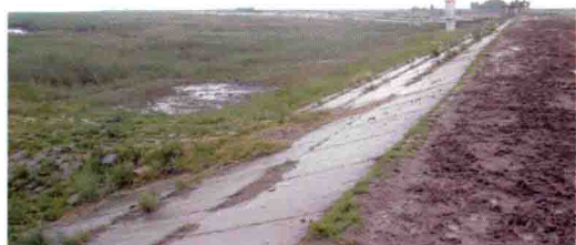
红旗泡水闸主坡背水种植被
