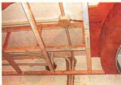
图1-6 吊顶构造
