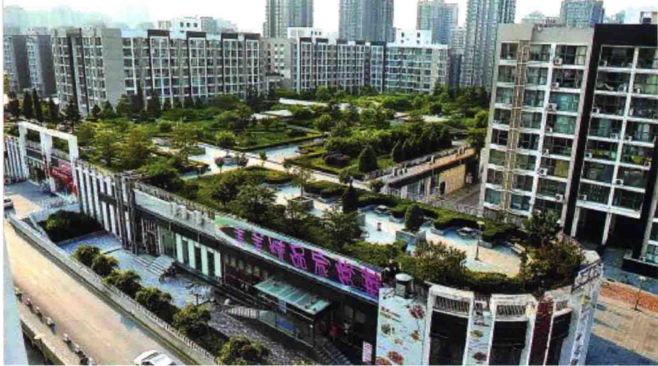
图 1-6 北京通惠屋顶花园
