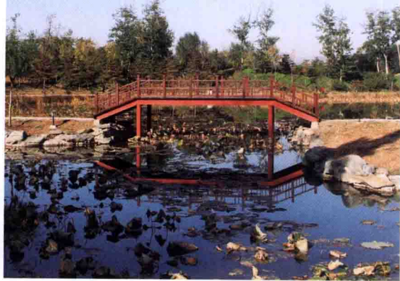
▲ 圆明园木梁桥
