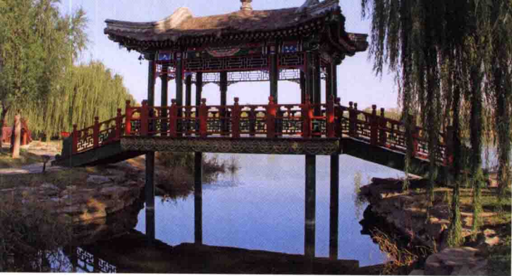
▲ 圆明园木梁桥
