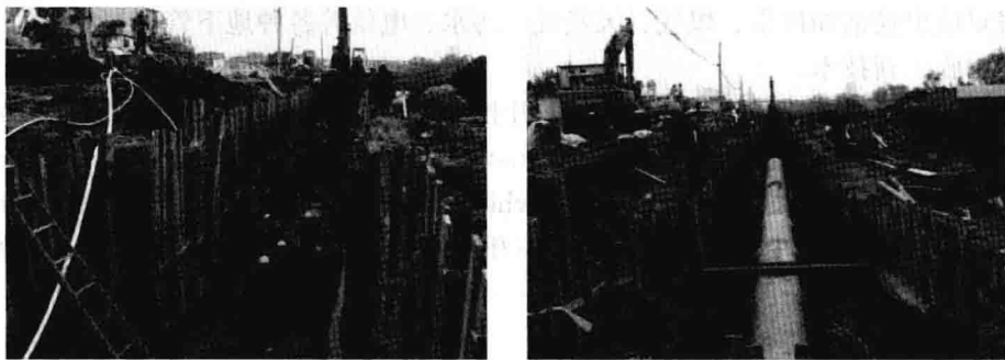
图 1-1 开挖施工法铺设地下管线
