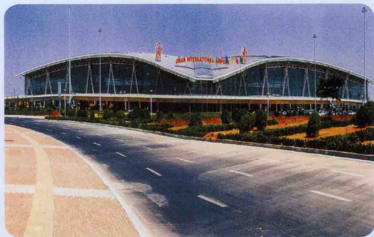
济南国际机场候机楼
