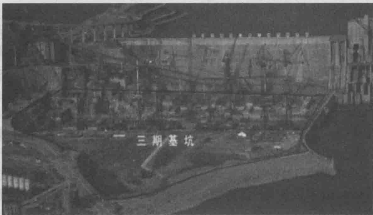
图 1.7 三峡工程三期碾压混凝土围堰正视图
