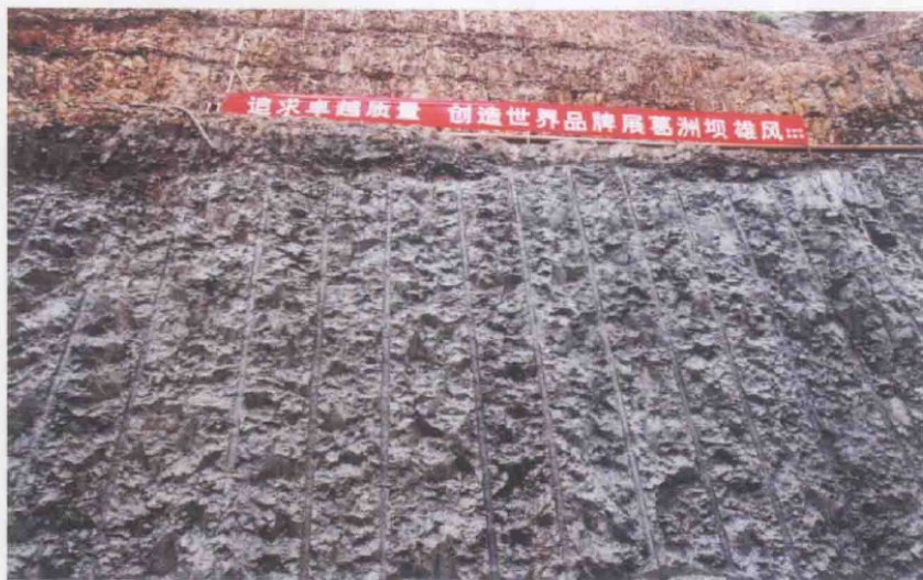
溪洛渡电站右岸导流洞进水口边坡（桩号0+000.0~0+150.0），以其精湛的施工工艺和良好的质量控制水平赢得了各方的高度评价，被评为溪洛渡“样板工程”。
