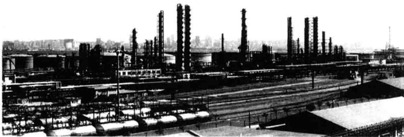
图0-1 某炼油厂区照片
