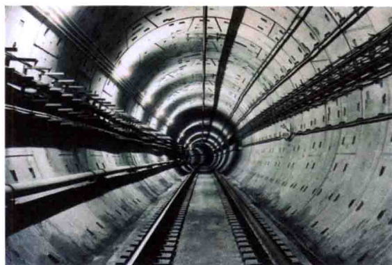
(a) 盾构隧道现场照片
