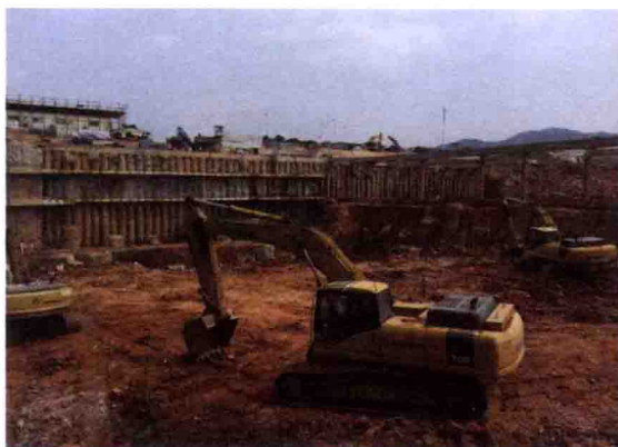
(a) 基坑开挖
