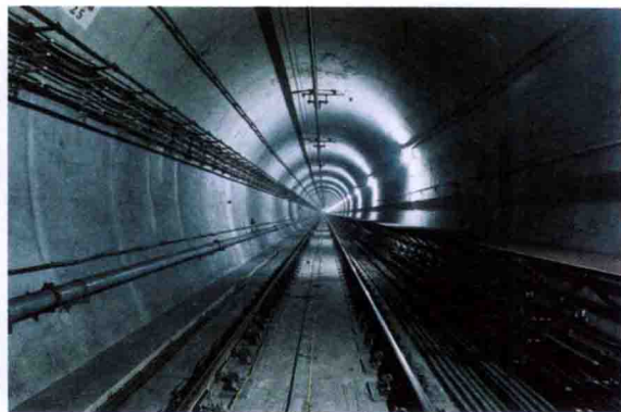
(b) 矿山法隧道现场照片
