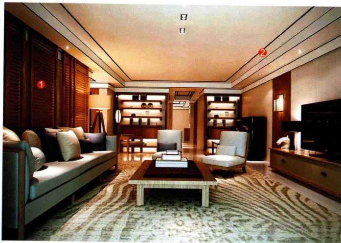
① 木格栅 ② 石膏板造型勾黑缝
