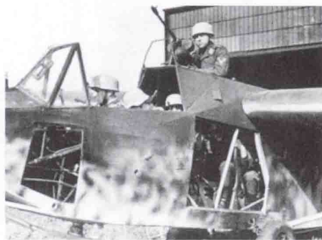
▲ 停留在地面上、满载空降兵 DFS 230B-1 型突击滑翔机，注意其机背部安装的一挺 MG 15 型机枪。
