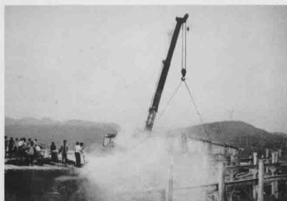
建设中的珍酒厂工地。
