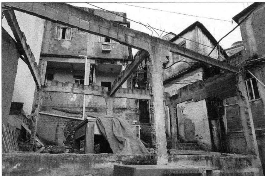
一所仅有“骨架”的房子，不知是正在修建还是已经被拆。
