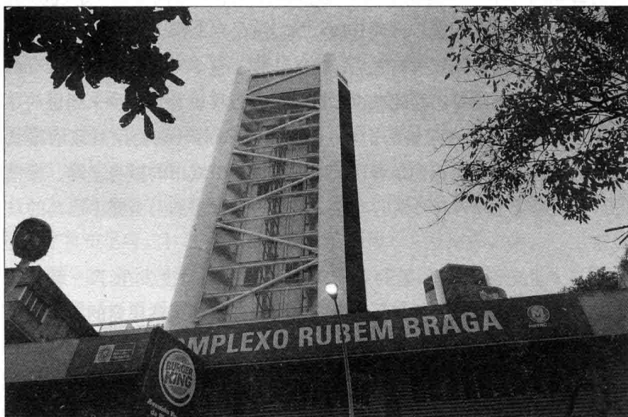
坎塔伽罗是里约唯一装有电梯的贫民窟。电梯的入口在山脚下的地铁站里。
