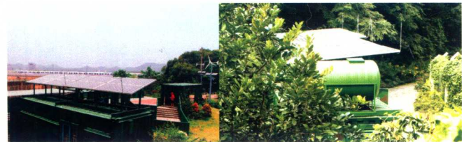
深圳梅林绿道——双道廊桥 集箱建筑太阳能光热利用
