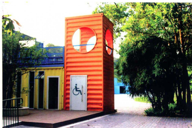
大运支线实景图
