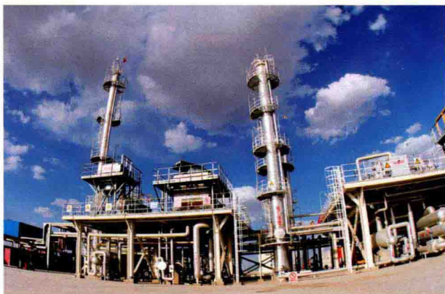
图 1-4 天然气处理站
