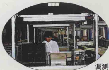
双星定时同步时钟系统 整机调测现场
