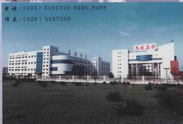
集团公司综合办公大楼
