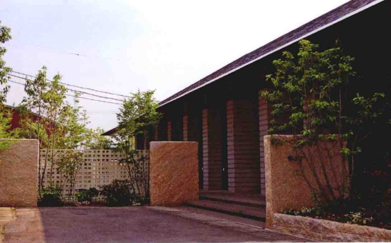
① 配合原有室外设计（外构），通过粗略切割花岗岩制作的古朴的石质墙壁和镂空砖砌的入口侧墙（北侧）。
